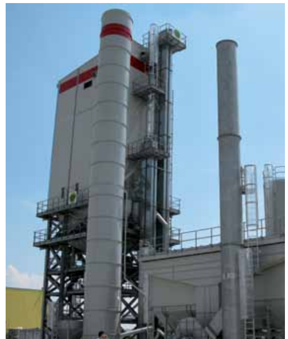
Impianto produzione asfalti - cortesia di Bernardi Impianti
