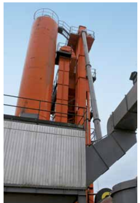
Filtro impianto asfalti
