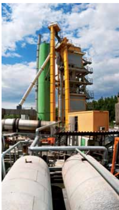
Impianto produttivo asfalti
