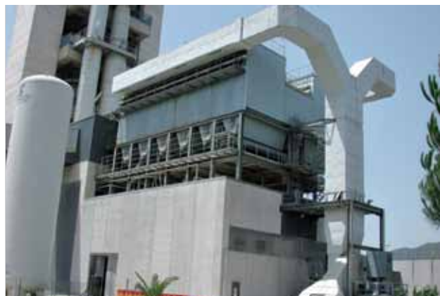
Filtri - impianto cemento
