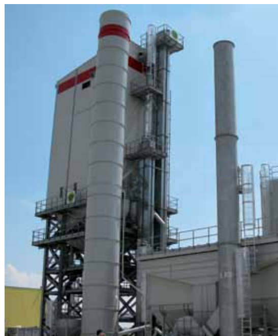
Impianto produzione asfalti - cortesia di Bernardi Impianti
