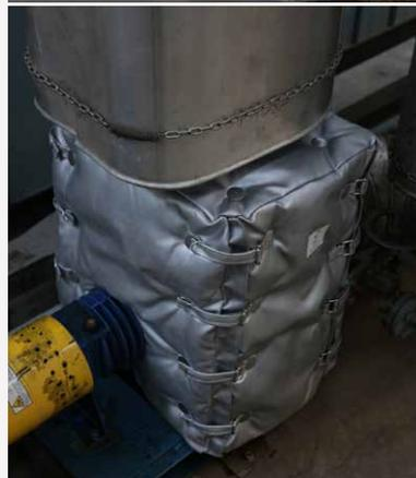
Gli *ENERSAVE* sono **cuscini smontabili e riapplicabili** pensati per la coibentazione di valvole e flange. Solitamente si fanno preferire ai sistemi di isolamento tradizionali per via della loro **facilità di montaggio**. L'uso dei cuscini *Enersave*, oltre ad evitare la dispersione di calore, aiuta a **prevenire infortuni** che potrebbero avvenire a causa di contatti accidentali con valvole o flange non isolate.
